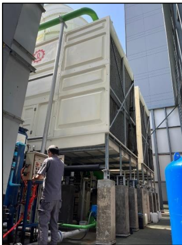
รูปที่ 2.2-7 ระบบหอผึ่งเย็น และช่องระบายอากาศธรรมชาติ
